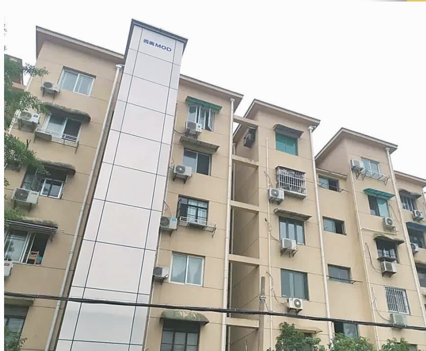
整体吊装完成
