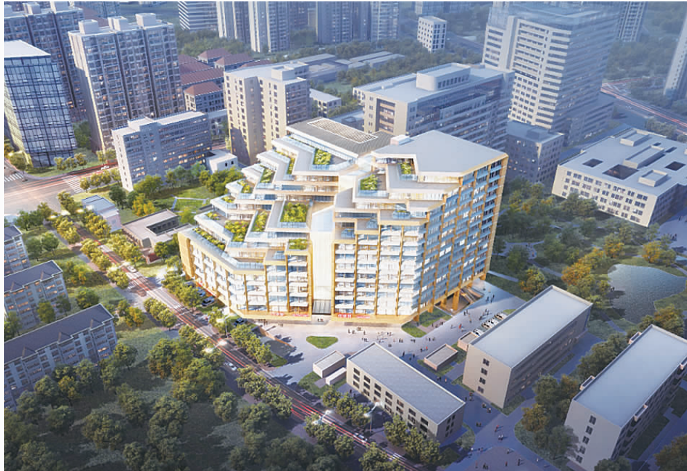
上海市第六人民医院骨科医学中心新大楼
