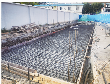
龙瑞路施工现场
