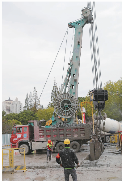
上海体育场站施工现场
