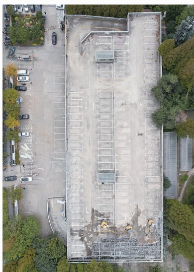
上海植物园站拆除立体停车库
