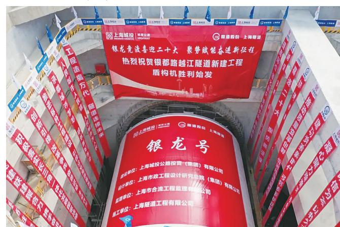
盾构机，刀盘开挖直径 15.43 米，总长 121 米，盾构体长度 14 米，最大推进速度 45 毫米 / 分钟，曾先后参建上海长江
