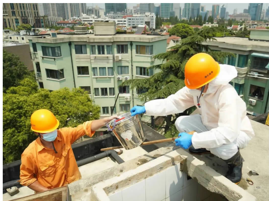
清洗楼顶水箱
