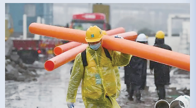
白猫方舱医院施工
