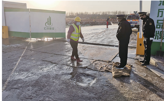
城管执法人员对在建工地进行检查
