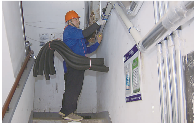
田林五六村的物业员工为水管穿上防冻“棉袄”
